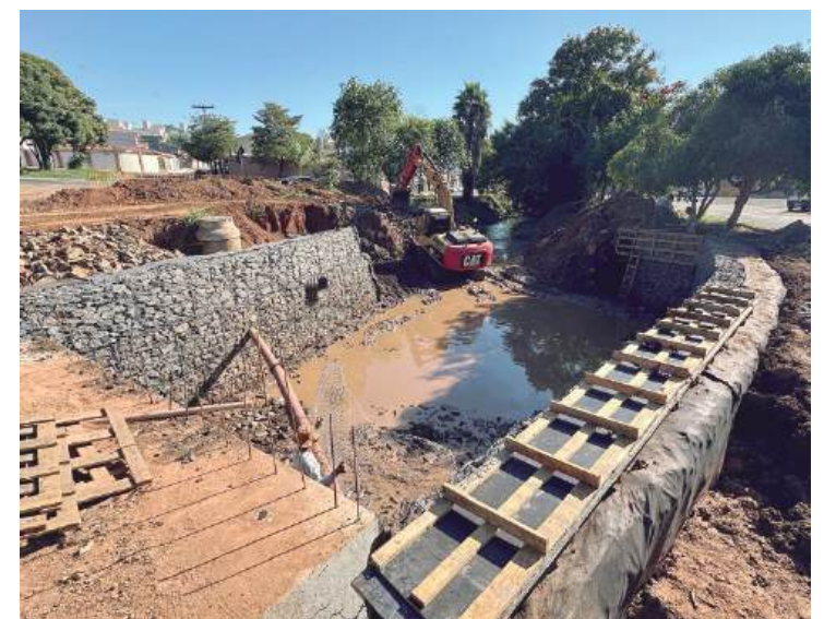
Prefeitura concluiu gabião em um dos lados da travessia e iniciou serviços no trecho oposto para reforçar a estabilidade do local
