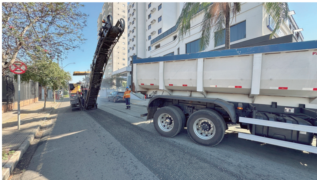
Importante via da região central, a rua Cristiano Cleopath passa por fresagem, antes de receber novo asfalto
