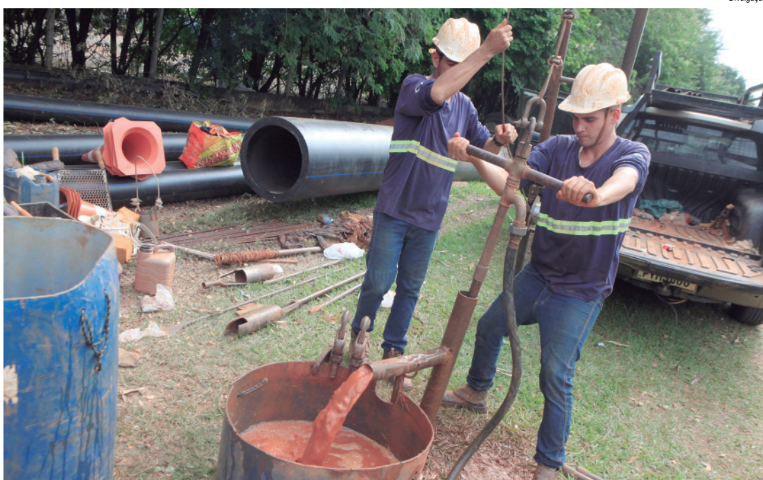
Equipes realizam sondagem do solo por meio do ensaio SPT etapa fundamental para garantir a qualidade e a segurança da obra (1)
