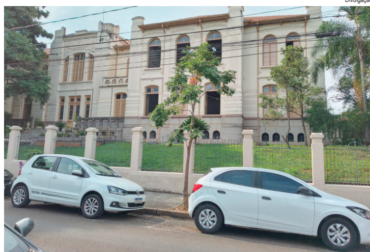
Com o recurso recebido, a direção da EE Sud Mennucci vai realizar reformas e melhorar o prédio centenário
