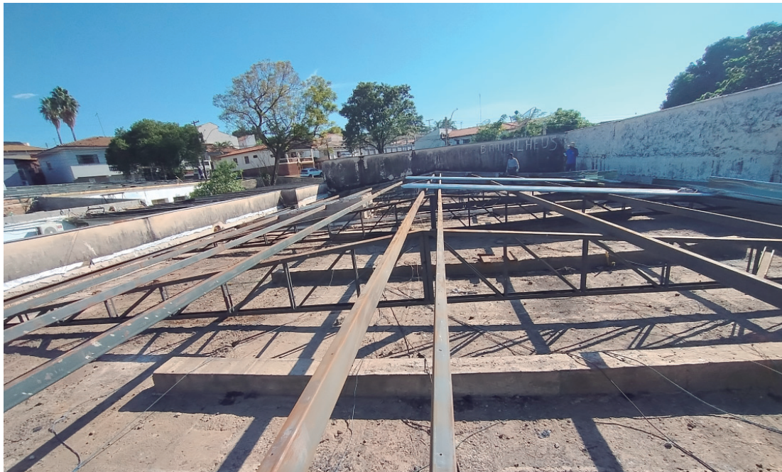
Novas telhas e calhas estão sendo colocados
