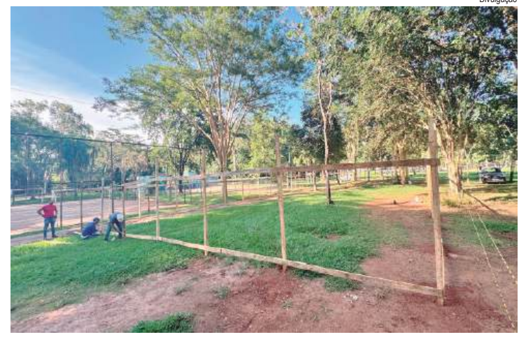
Canteiro de obras sendo instalado no local
