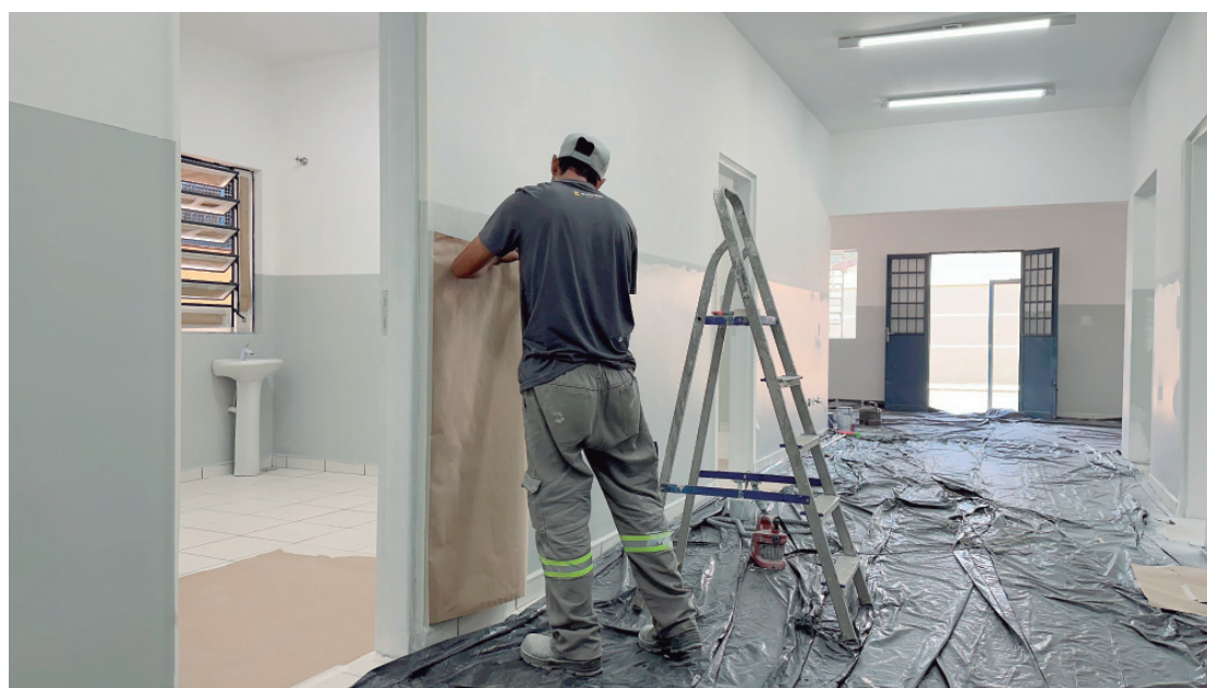
Parte interna da unidade também recebe pintura
