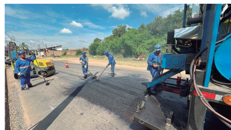
Avenida Bebedouro, no bairro Vila Sônia, foi uma das vias beneficiadas
