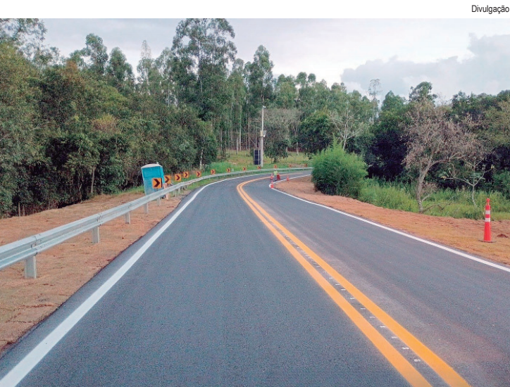
Concessionária recupera três pontos de erosão entre os km 232 e 236 e faz melhorias no sistema de drenagem
