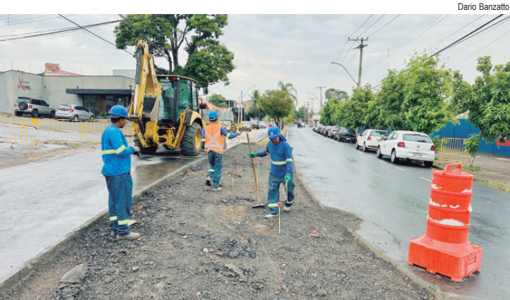
Obras na Av. Nove de Julho alteram trânsito no bairro Castelinho
