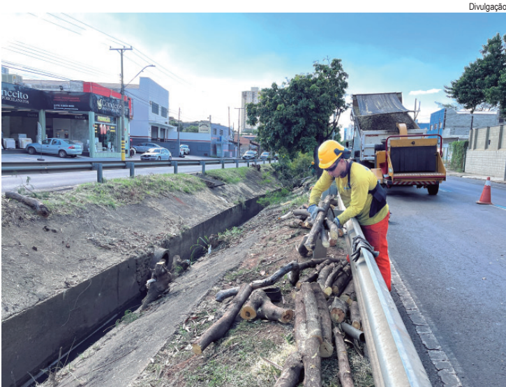
Limpeza consiste na retirada de galhos, mato e árvores inadequadas (leucenas) nascidas dentro do canal
