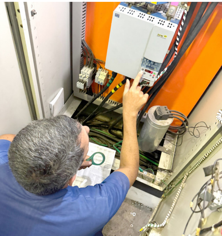
Equipamento 'soft starter' está sendo instalado em todos os painéis furtados nesta madrugada
