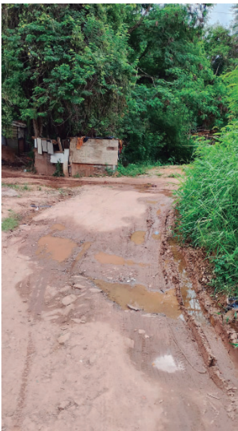
Os buracos e a lama tomam conta de rua da comunidade Renascer
