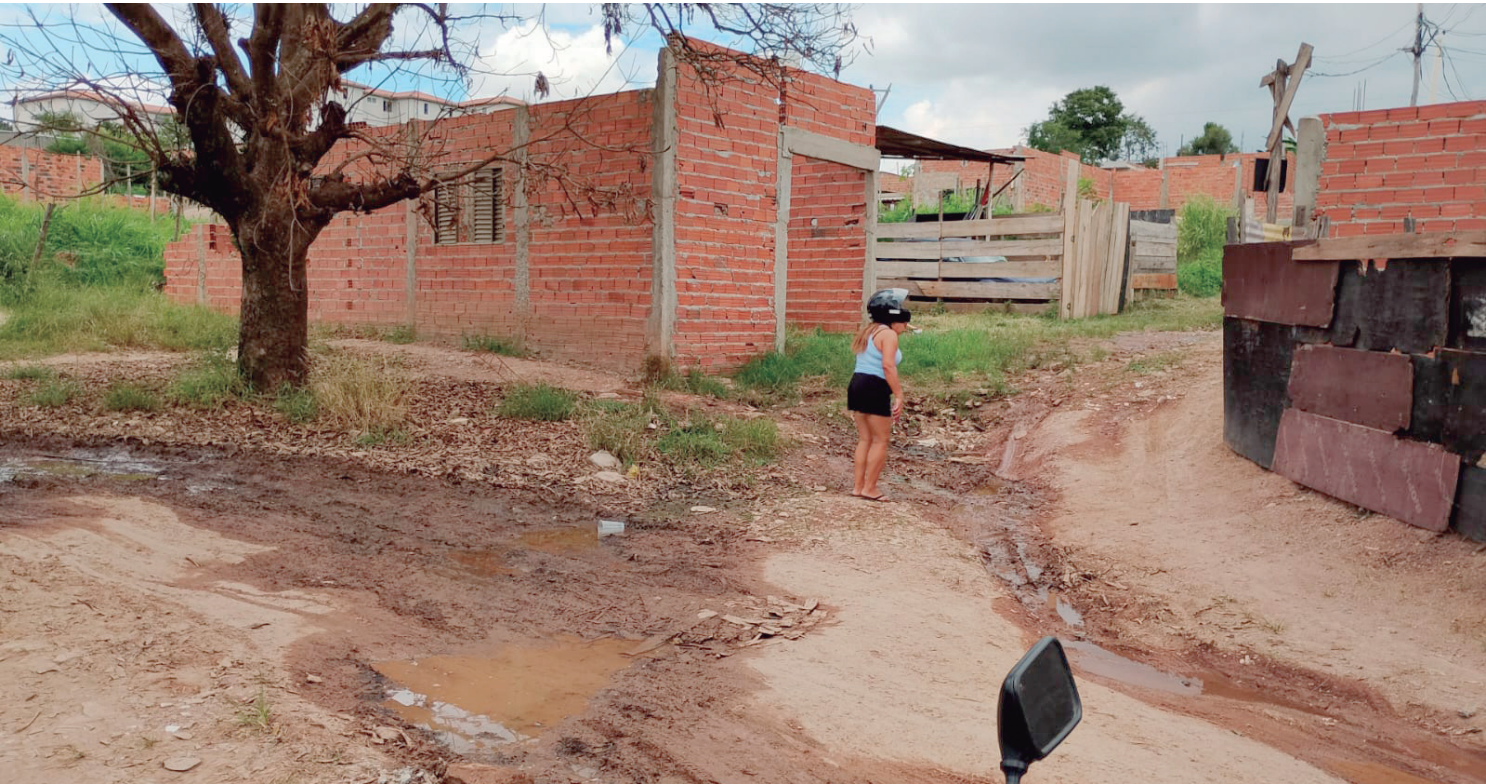
Os buracos e a lama têm dificultado a locomoção de moradores da comunidade Renascer
