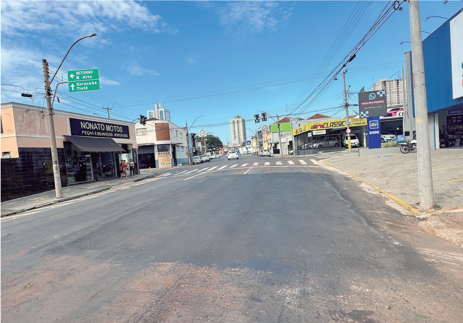
Serviços incluíram substituição da antiga canalização de tijolos por uma estrutura em concreto, mais resistente e durável
