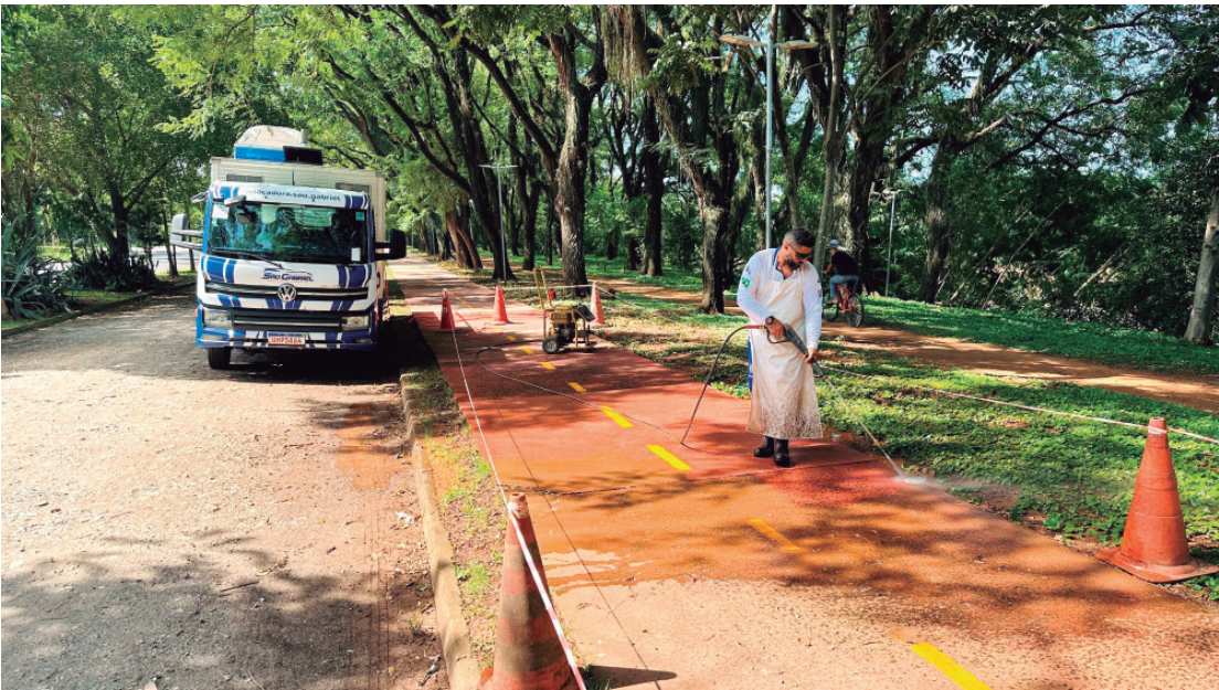
Entre as melhorias na ciclovía estão instalação de faixas elevadas para pedestres e piso drenante na pista de caminhada
