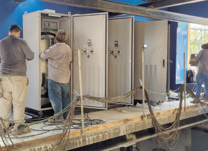
Captação 1 recebe instalação de novos painéis elétricos com inversores de frequência
