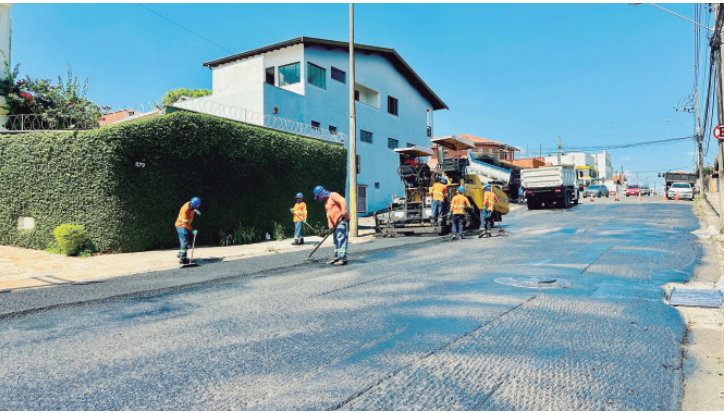
Prefeitura inicia aplicação de massa asfáltica na avenida Pompeia
