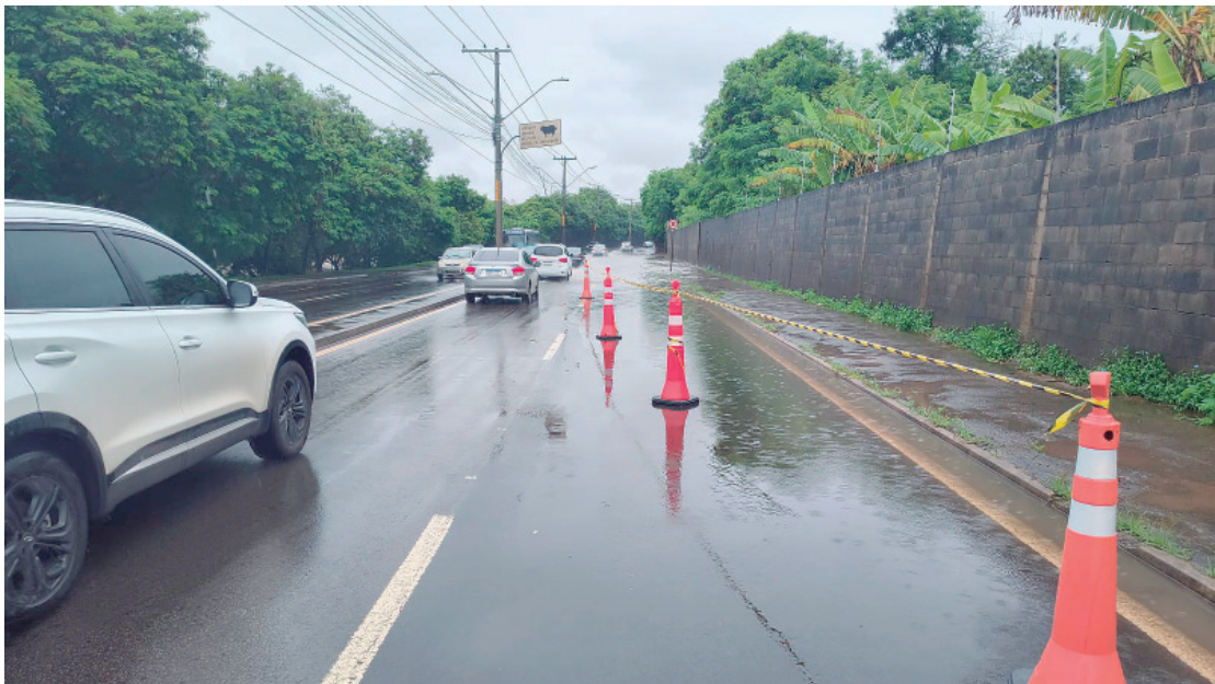
A Av. Jaime Pereira foi parcialmente interditada no acesso à Empresa Eco Terra, sentido centro-bairro
