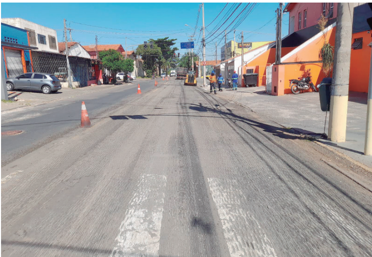
Pedro Kawai verifica os serviços de recapeamento na avenida Pompeia
