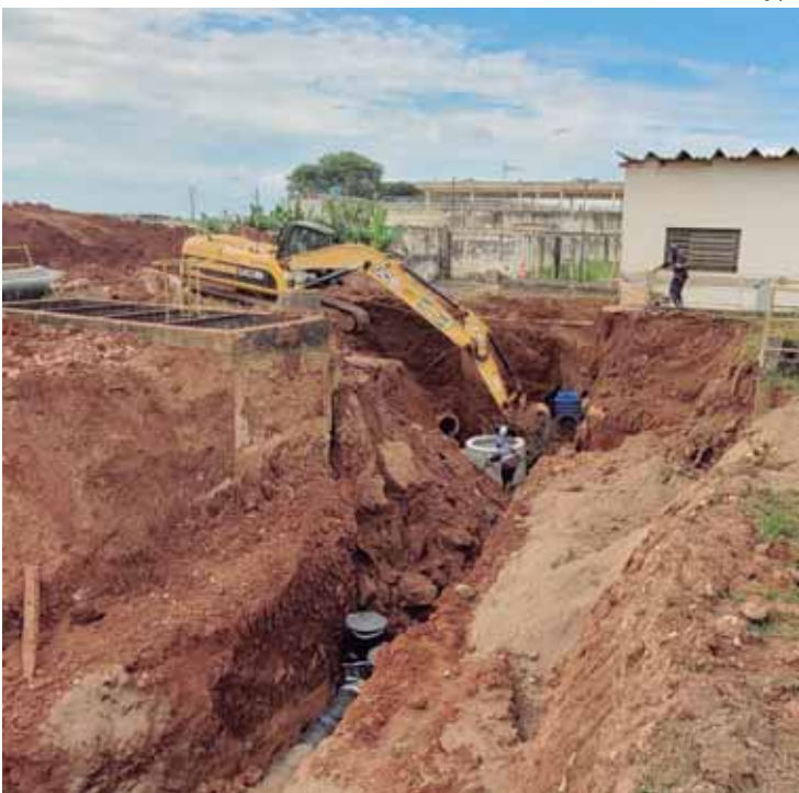
Nova Adutora Capim Fino-Santa Teresinha está em etapa final de construção
