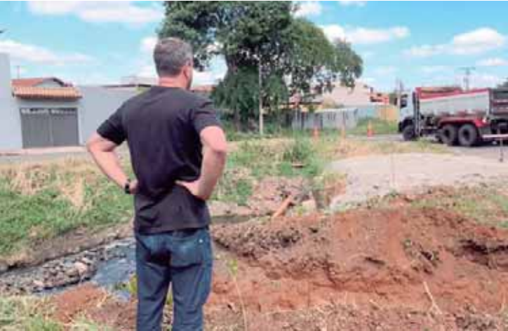
Obra sobre o córrego integra o conjunto de melhorias em microdrenagem realizadas no município
