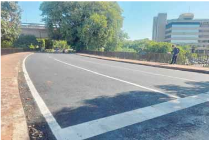
Manutenção asfáltica no viaduto foi realizada pelo Executivo
