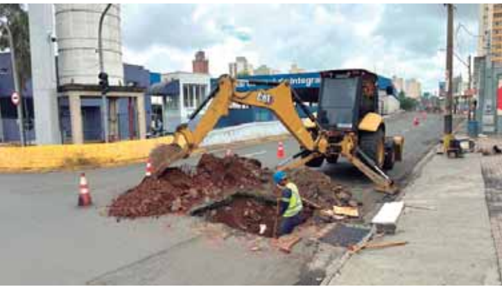
Tamém estão sendo feitas adequações no sistema de drenagem da avenida, com instalação de nova tubulação e melhorias nas bocas de lobo
