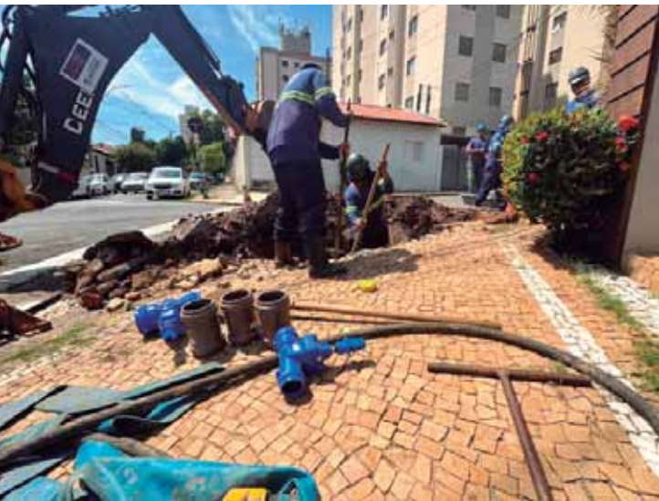
Após o feriado de Carnaval, programa de Setorização da Rede esteve na região do bairro São Dimas
