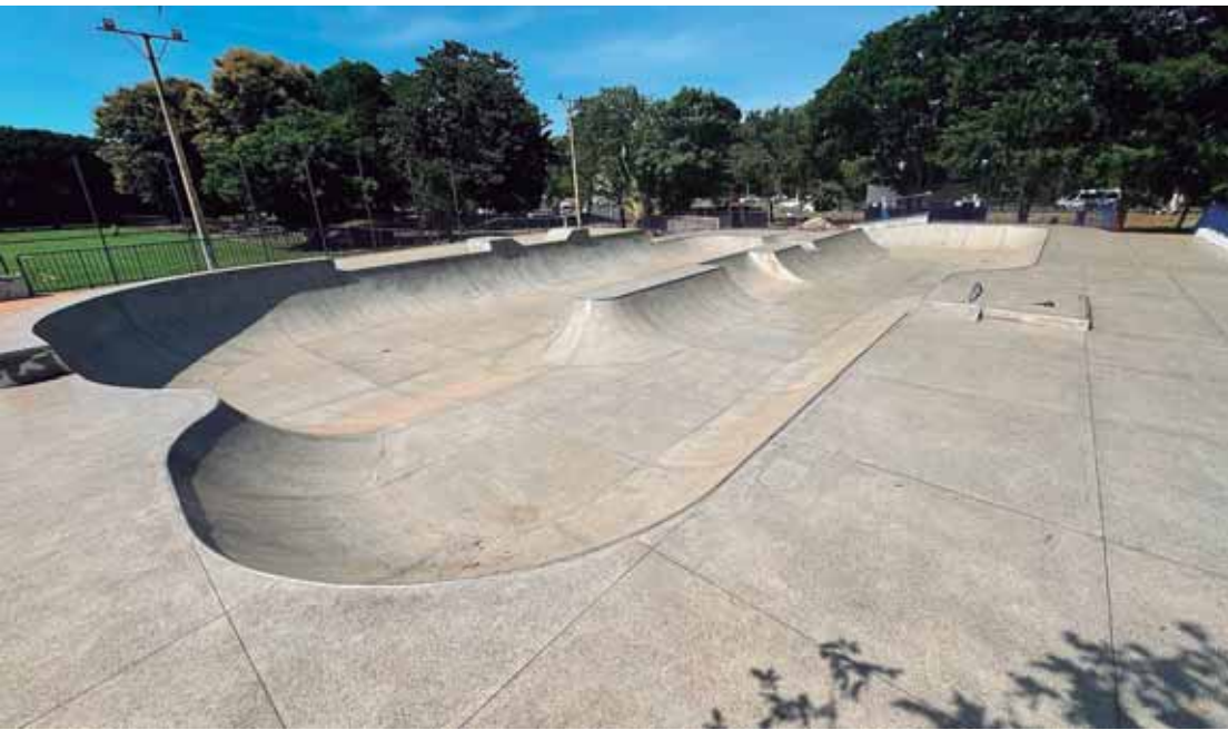
Pista está praticamente concluída, restando apenas serviços pontuais.
