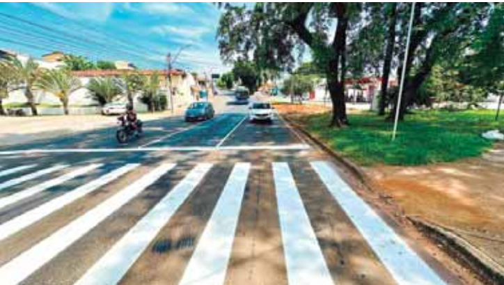
Intervenção contemplou a substituição de aproximadamente 150 metros de rede, no trecho entre a rua Tamandaré e a rotatória da avenida Prof. Alberto Vollet Sachs
