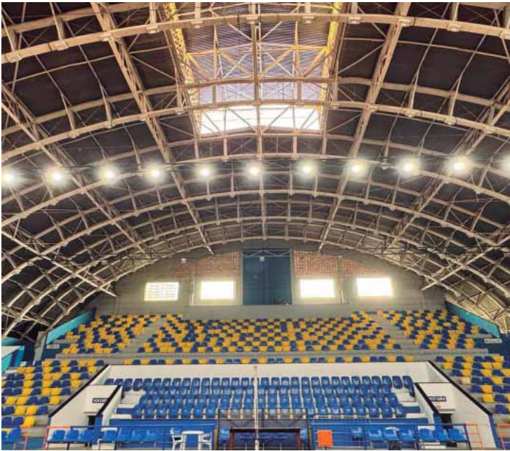
Troca do fechamento do lanternim no teto do Ginásio Municipal (superior ao centro)
