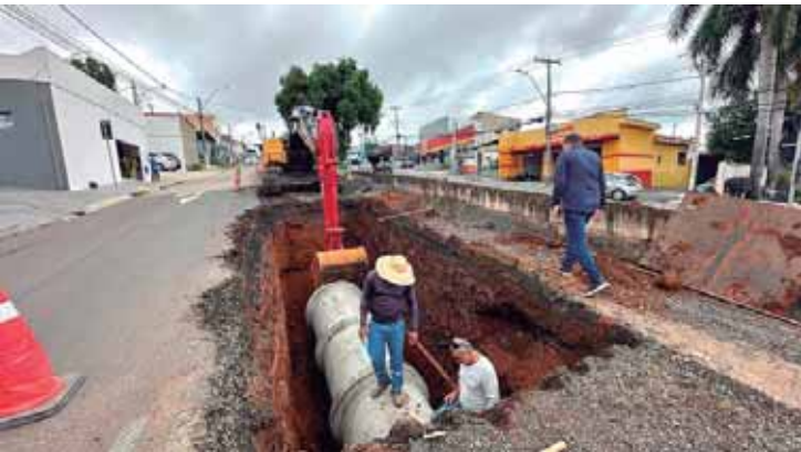
Na avenida Piracicamirim, as equipes retomaram os trabalhos, que envolvem a substituição de aproximadamente 150 metros de rede
