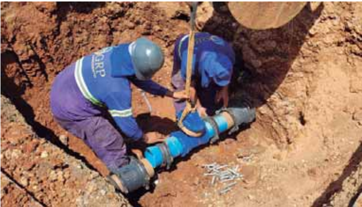
Sema segue com ação de setorização para instalação e substituição de registros de rede
