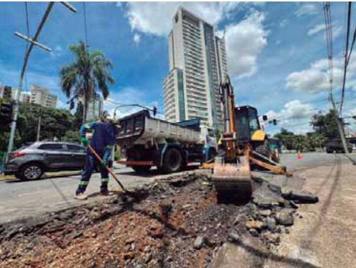
Os trabalhos têm como objetivo a correção de pontos de afundamento do solo, conhecidos popularmente como borrachudos
