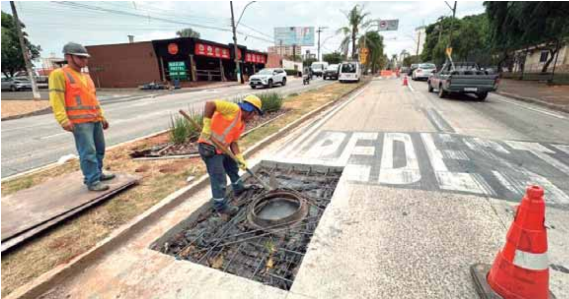
Administração avaliou qualidade das obras de recape e concreto já executadas no município; quatro vias foram refeitas
