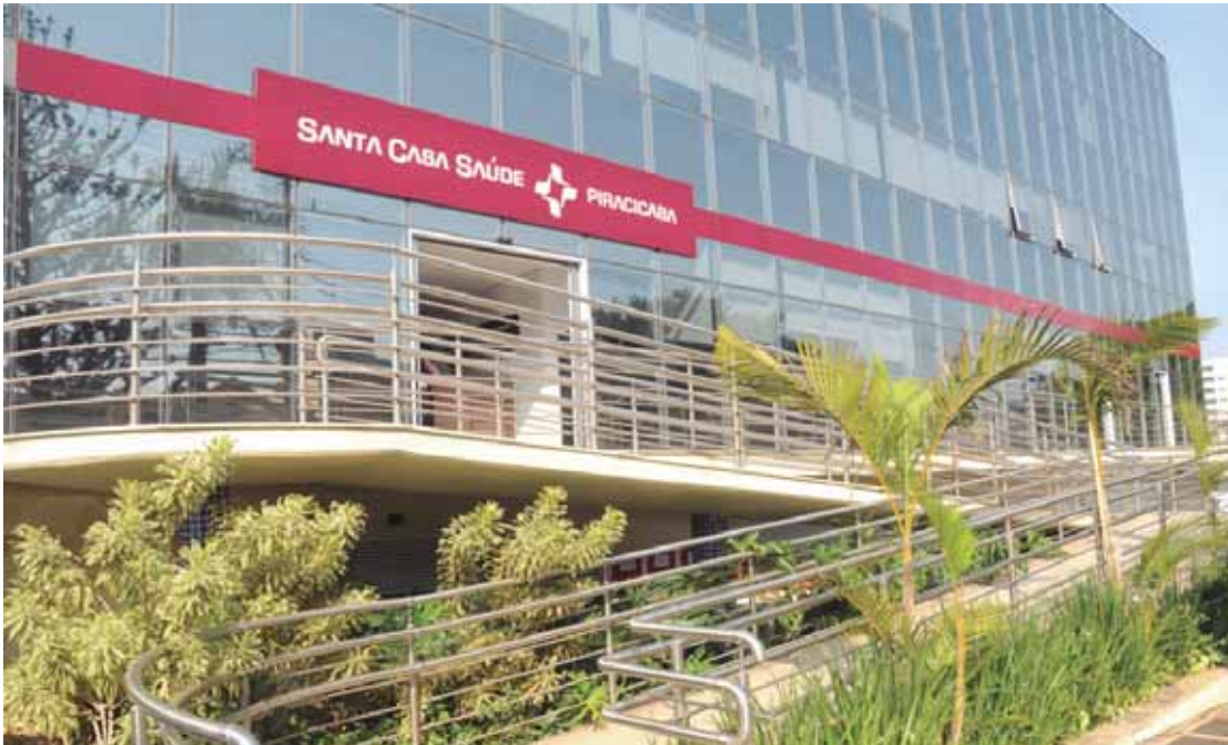
O novo prédio do Santa Casa Saúde ocupa três andares de estrutura moderna, ampla e climatizada onde atuam as equipes multiprofissionais do Plano
