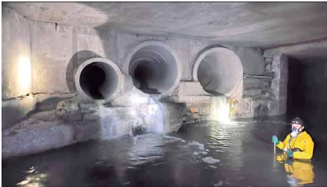
Técnico da Mirante durante inspeção no Ribeirão Itapeva
