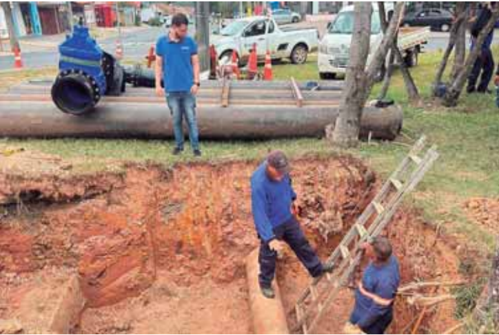
Gustavo Pompeu visitou na manhã desta terça (2) o canteiro de obras da nova adutora, que terá 1,4 quilômetro de extensão
