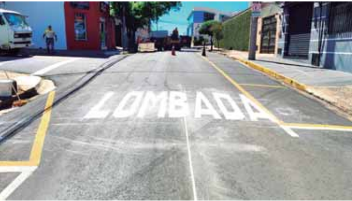
Prefeitura realizou serviços de reforço na sinalização de 33 vias
