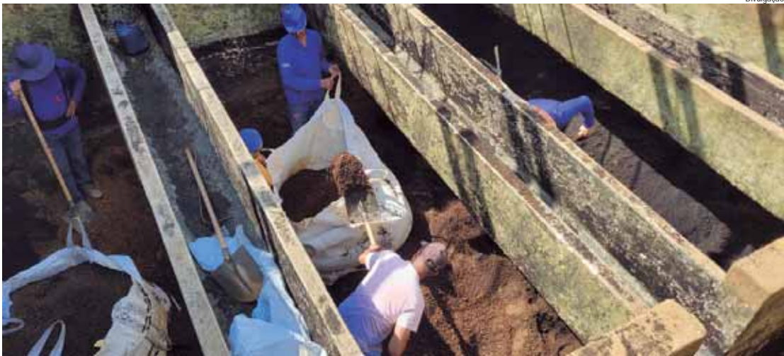
Cinco filtros receberão melhorias com a troca do material filtrante
