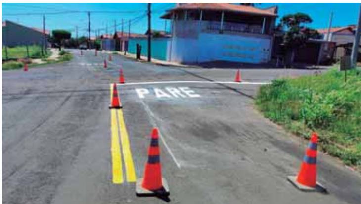
Rua Gentil Polezi recebeu reforço na sinalização de solo
