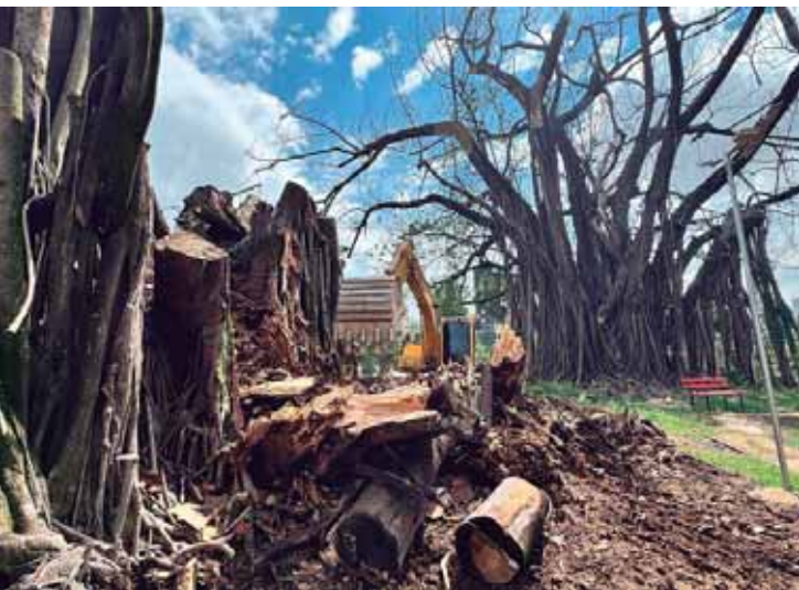
Prefeitura executa a remoção das raízes e do tronco de outra falsa seringueira no Parque do Mirante, que foi suprimida no ano passado
