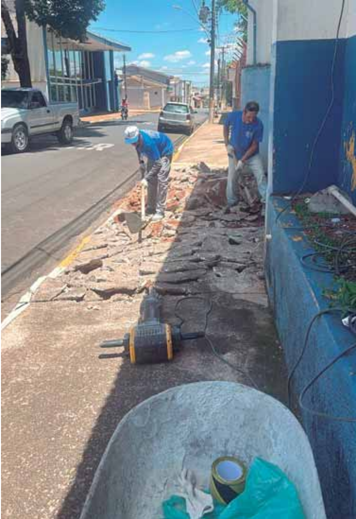
Reforma teve início com a manutenção das calçadas
