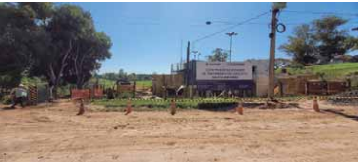
ETL Anhumas está sendo construída ao lado da Estação de Tratamento de Água
