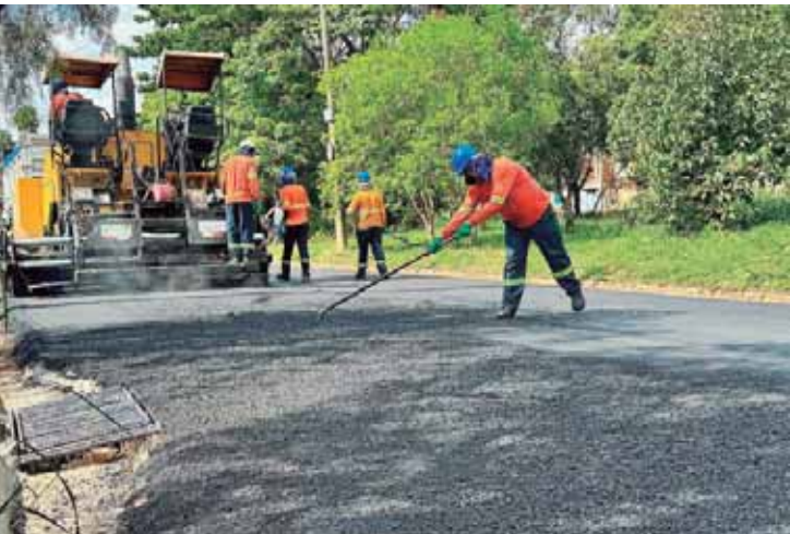
Serviços se concentram na avenida Pio Sbrissa, que está recebendo aplicação da nova camada de asfalto
