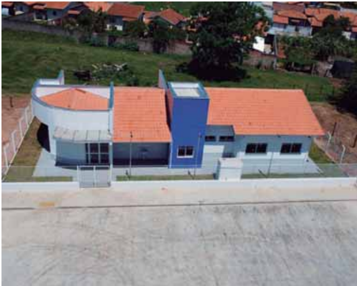
Centro Especializado de Assistência Social (CREAS) está sendo construído no bairro Portal das Flores
