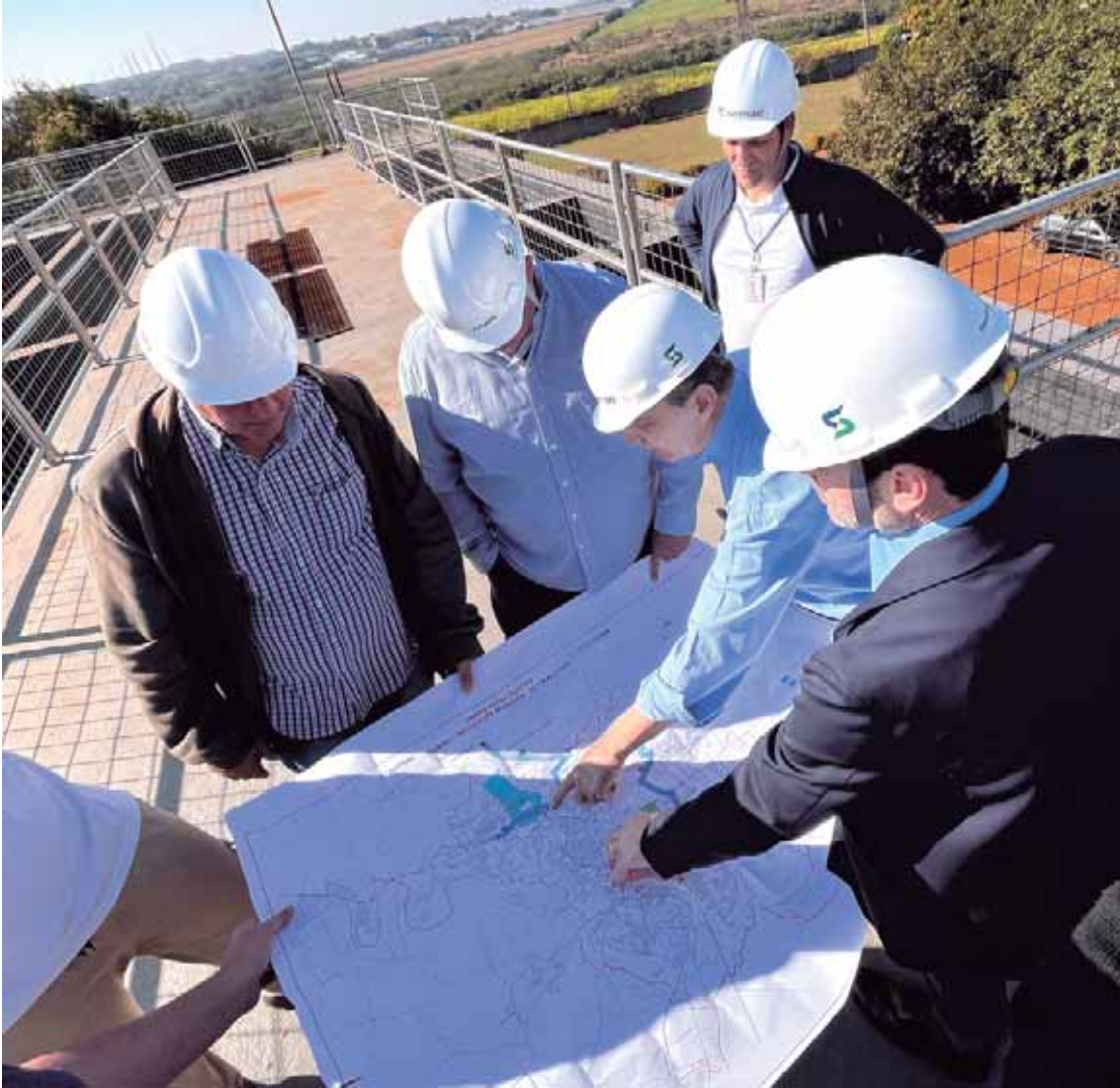
Prefeito Helinho Zanatta acompanhou o presidente do Semae Ronald Pereira em recente visita às obras de ampliação da ETA Capim Fino
