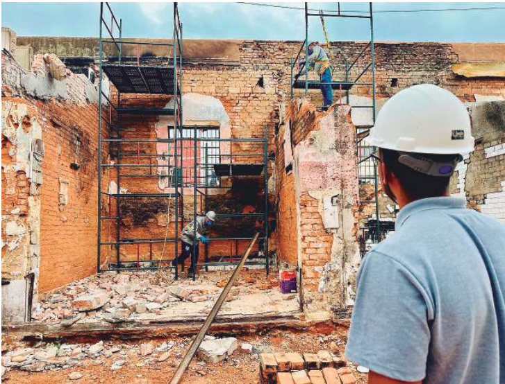
As obras de reconstrução do Mercado Municipal tiveram início segunda-feira, 27
