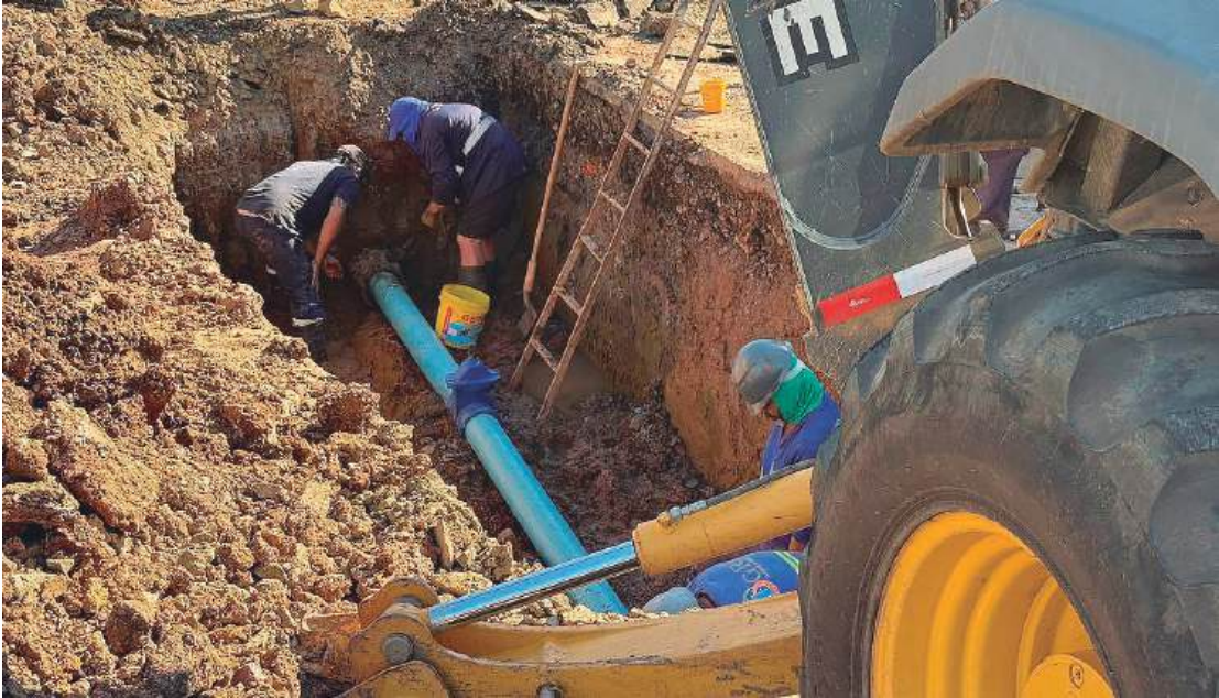
Obras de Setorização da rede vão beneficiar, inicialmente, mais de 100 mil pessoas na região Norte da cidade
