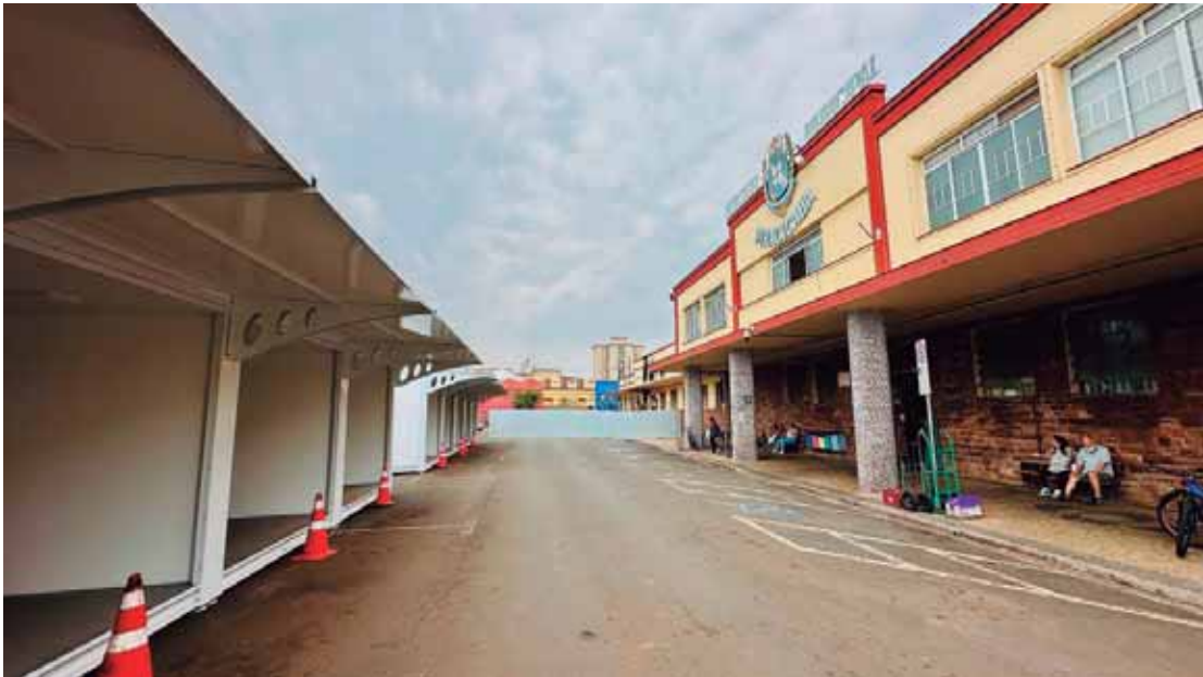
Prefeitura concluiu a instalação dos 16 boxes provisórios no Mercado Municipal
