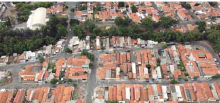
Vista aérea da região dos três núcleos que serão atendidos
