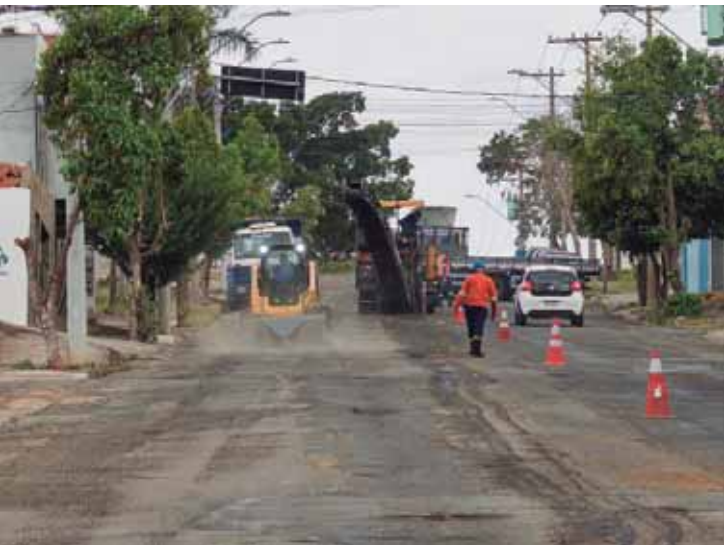
Prefeitura dá início aos serviços de fresagem na avenida Raposo Tavares, que receberá novo pavimento
