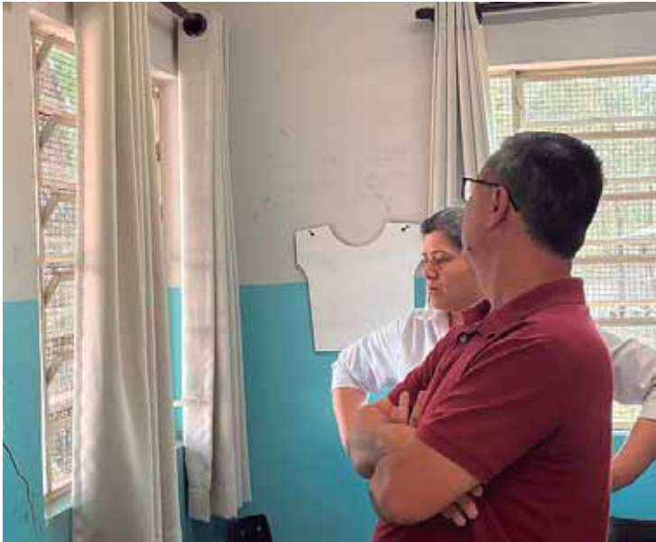
Pedro Kawai solicita melhorias em posto de saúde após constatar rachaduras e presença de escorpiões
