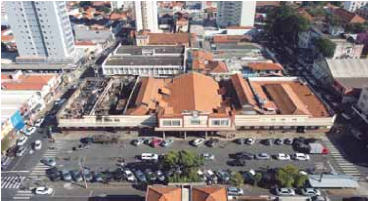
Prefeitura vai iniciar instalação de boxes modulares no Mercado Municipal; estacionamento ficará interditado
