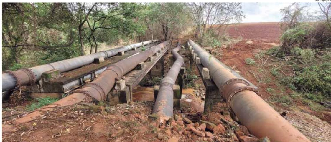
Rede de 600mm rompida próximo a captação-3 (Capim Fino) devido a oscilação de energia elétrica na última segunda-feira, 22
