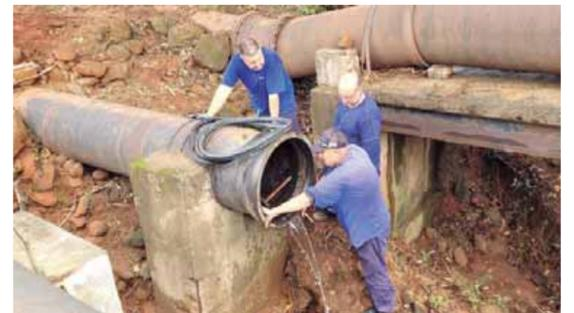
Antes de receber nova tubulação, servidores fazem a troca da vedação dos sistemas para encaixe da rede
