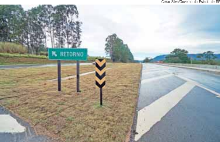
As obras beneficiam diretamente 16,1 mil moradores e geraram 708 empregos
