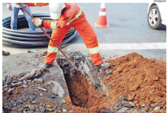
Troca de Rede pelo MND visa a substituição de tubulações enterradas sem a necessidade de abertura de grandes buracos
