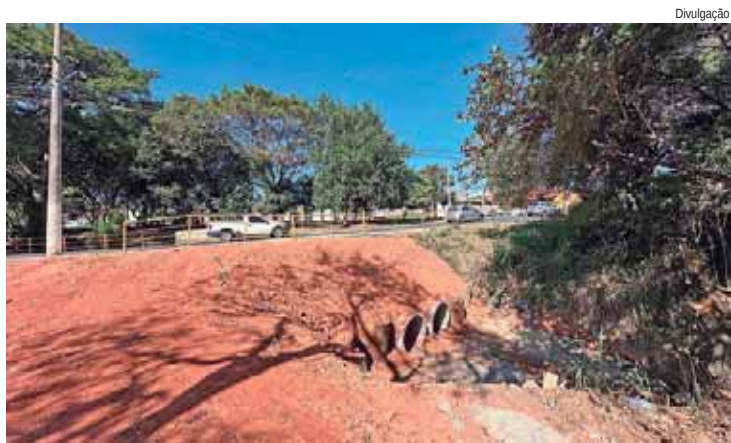
Serviço foi necessário após erosão comprometer a travessia do córrego que passa sob a rua Clara Nunes
