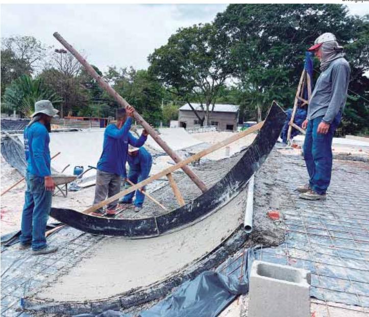
Pista recebe concretagem das áreas dos pisos em curvas
