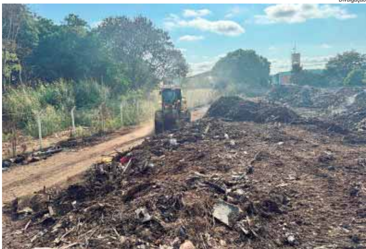
Prefeitura executa retirada de material e limpeza do ecoponto do Jardim Oriente
