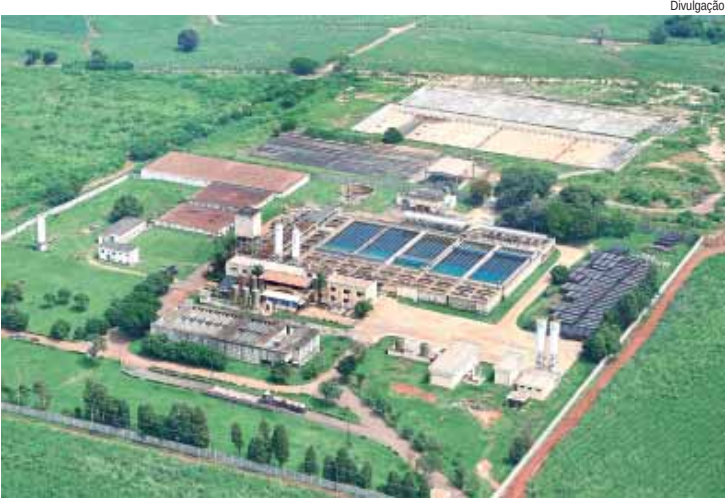
ETA Capim Fino passará por manutenção preventiva e corretiva no domingo (25)
