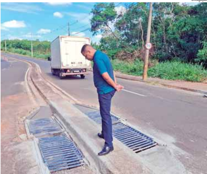
Thiago Ribeiro acompanhou instalações de galerias pluviais na avenida
